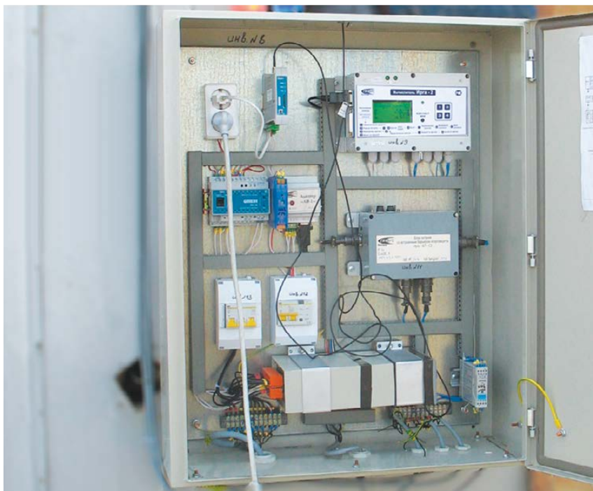
Фото 1 — Узел учета и контроля расхода газа. Пустыня Каракумы (Туркмения)
